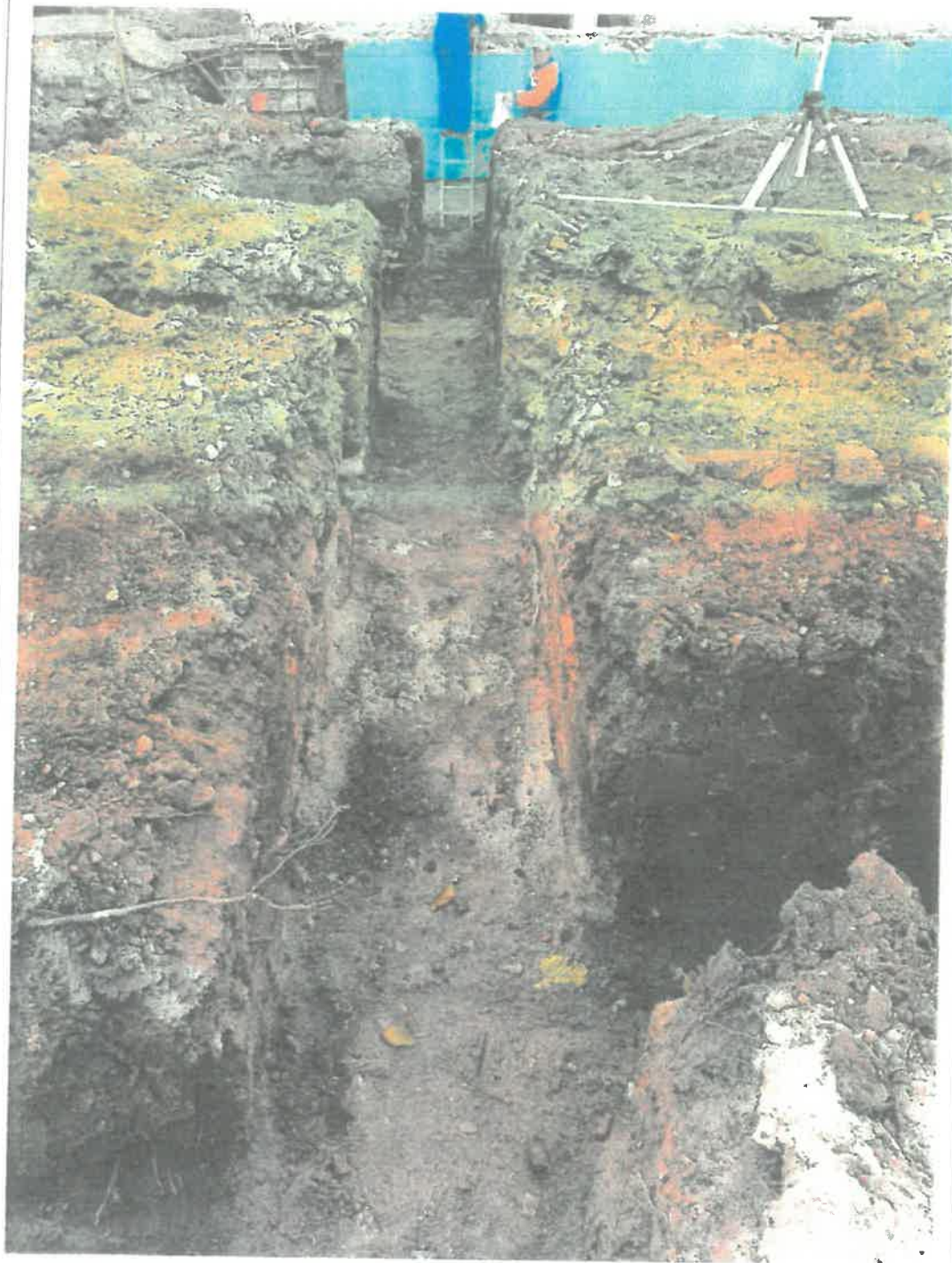
Poza Nr.3 – Se observă starea săpăturii în lungul axului S2 4
