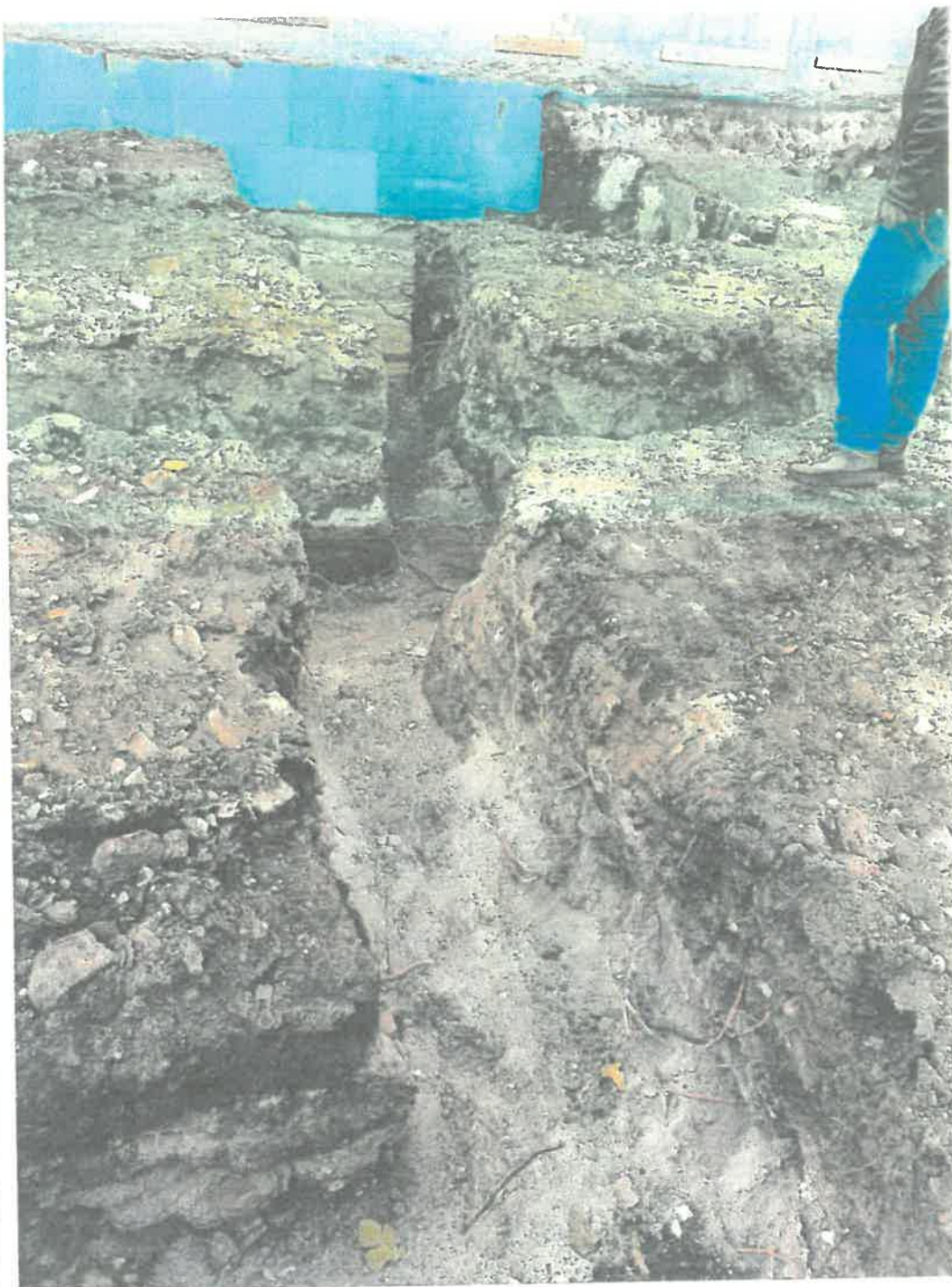
Poza Nr.4 – Se observă starea săpăturii și straturile de umplură neomogenă
